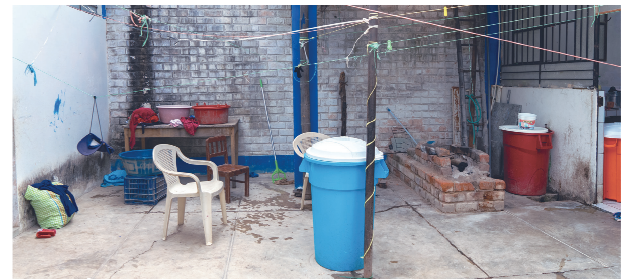
Espacios exteriores de lavandería con depósitos de agua de albergue en la región Piura | © OIM Perú 2023
