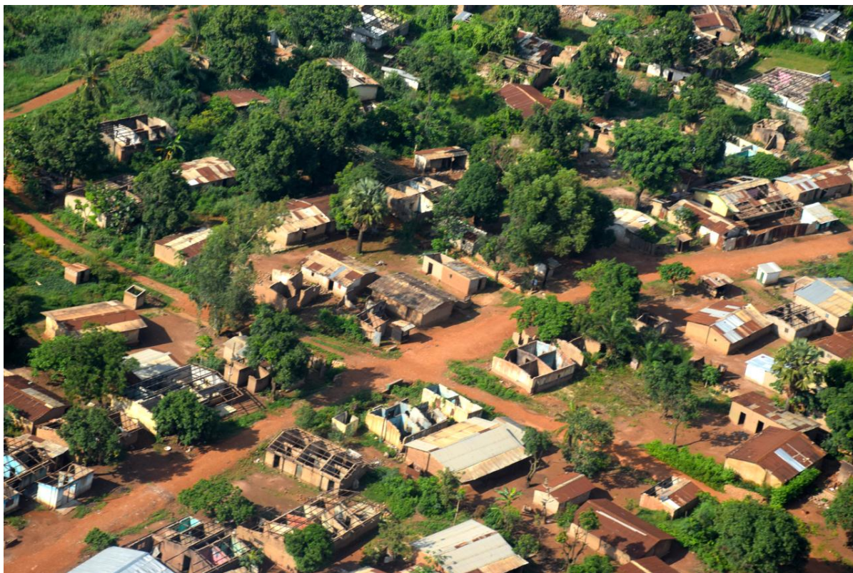
Vue aérienne de maisons détruites Quartier de Kokoro, dans le 3 ème district de Bangui
