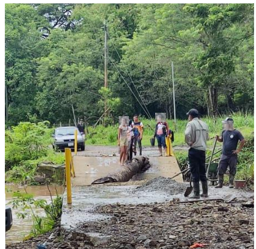
Paso de personas ante colapso de puente. La Cruz, Guanacaste, Costa Rica. © OIM 2022/Yanansy RODRÍGUEZ
