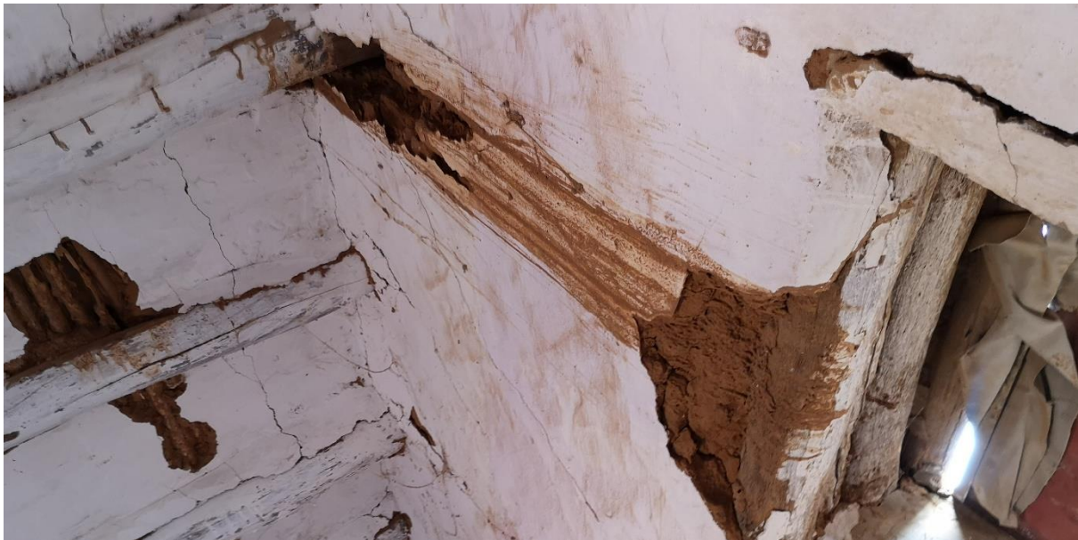
Image 2 : Toit d'une chambre vue de l'intérieur, dans un mahadra à Sélibaby
