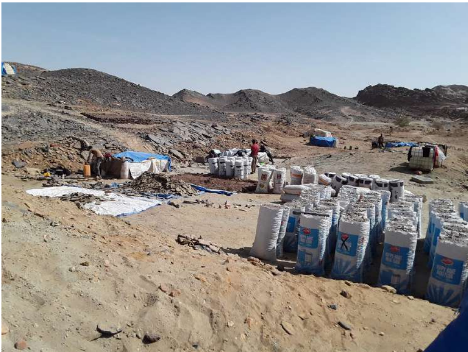
Photo 4 : Zone de traitement des roches, site de Tabelot.
